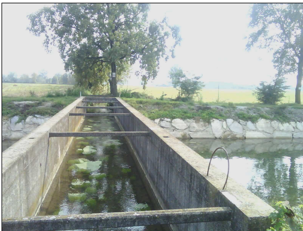
Il ponte canale della Roggia Orrida sul Vacchelli
